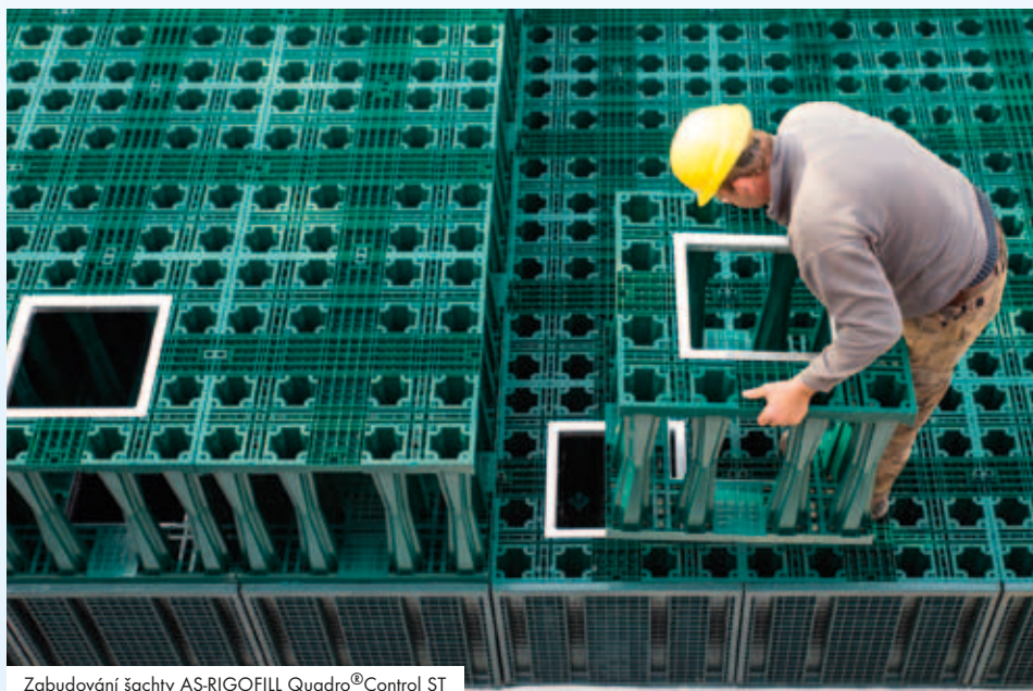
Zabudování šachty AS-RIGOFILL Quadro®Control ST
