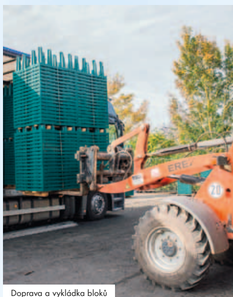
Doprava a vykládka bloků
