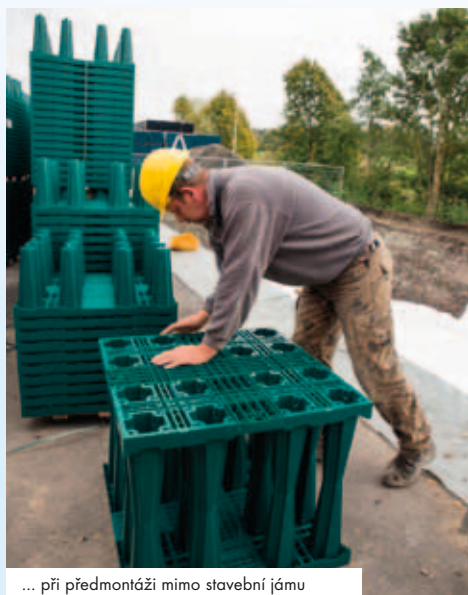
... při předmontáži mimo stavební jámu
