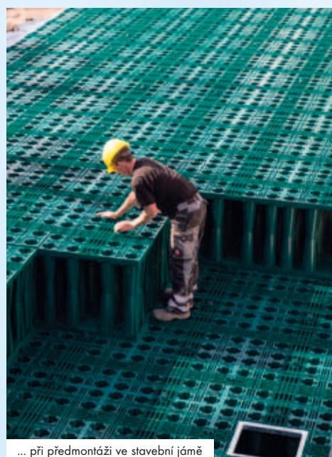
... při předmontáži ve stavební jámě
