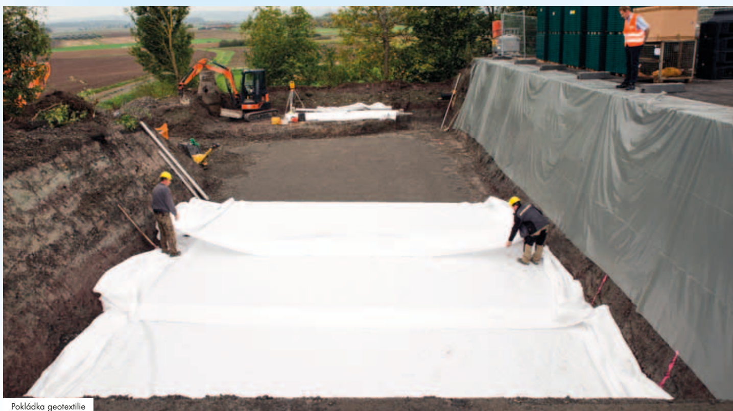
Pokládka geotextilie
