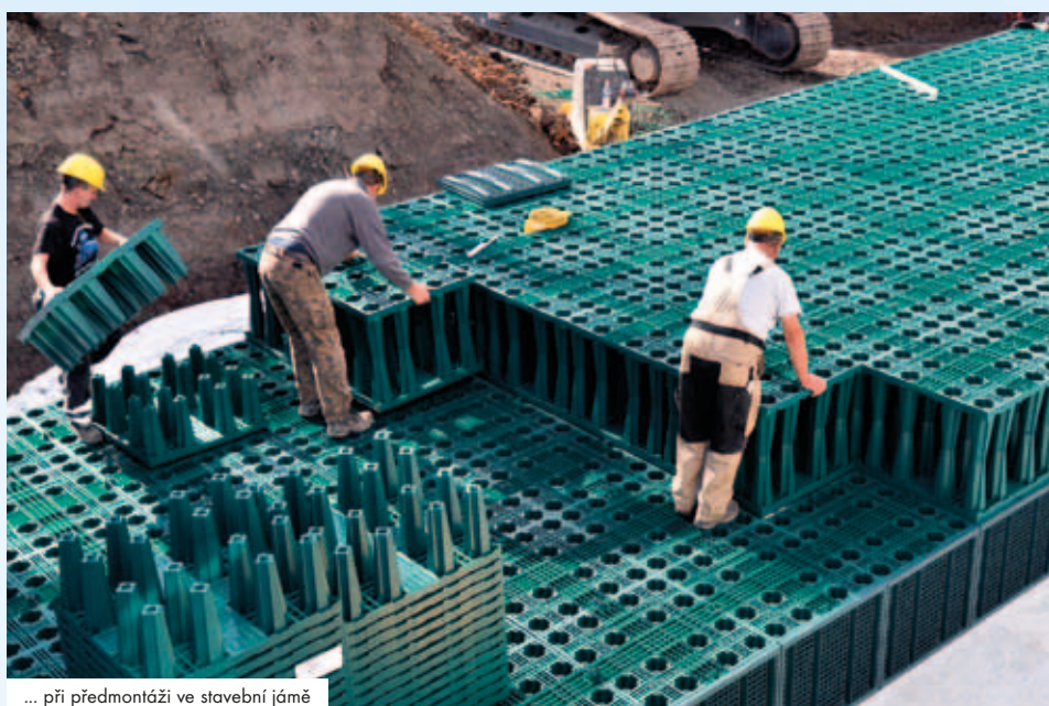
... při předmontáži ve stavební jámě
