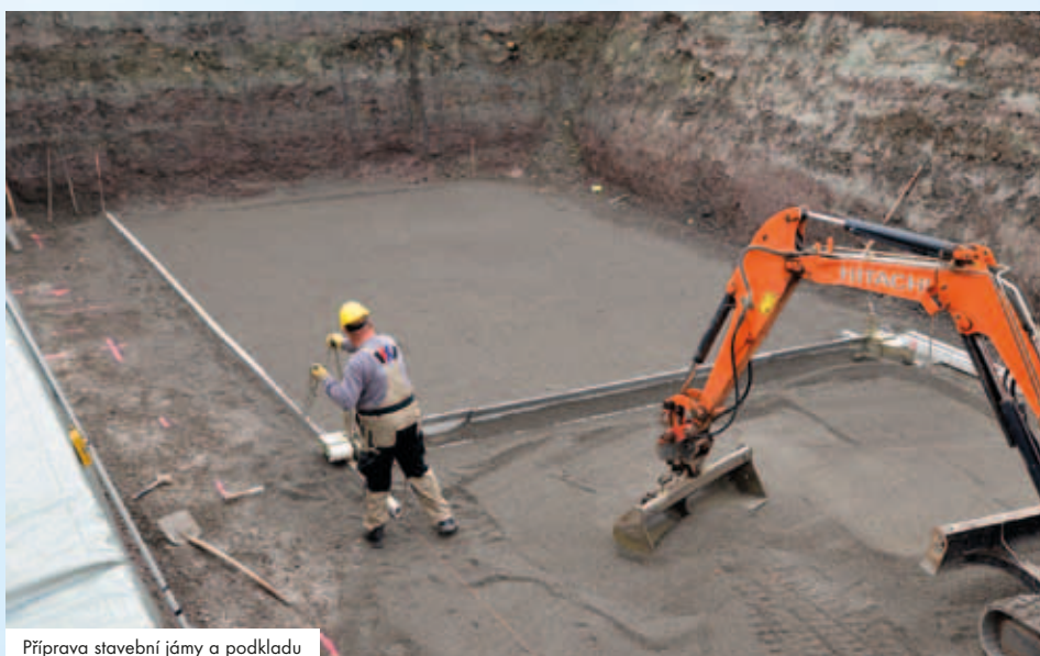
Příprava stavební jámy a podkladu
