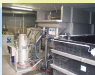
Příklad osazení flotační jednotky AS-FLOT 3,6
