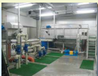
Příklad osazení flotační jednotky AS-FLOT 40
